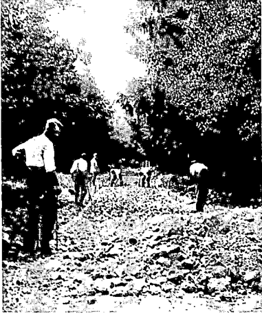
Wegebau, Kirchweg von Hausen nach Hoch-Weisel
